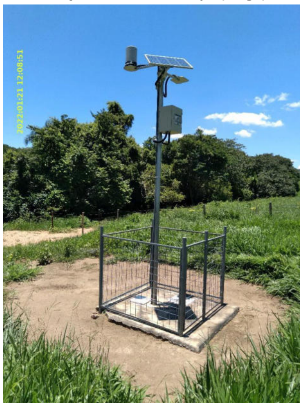
Estação Telemétrica Limpa (longe)
