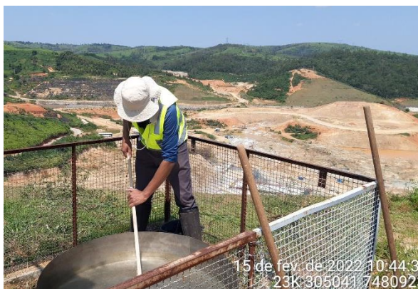
Foto 3 – Realização da atividade de limpeza da EMA. (Data: 15/02/2022).
