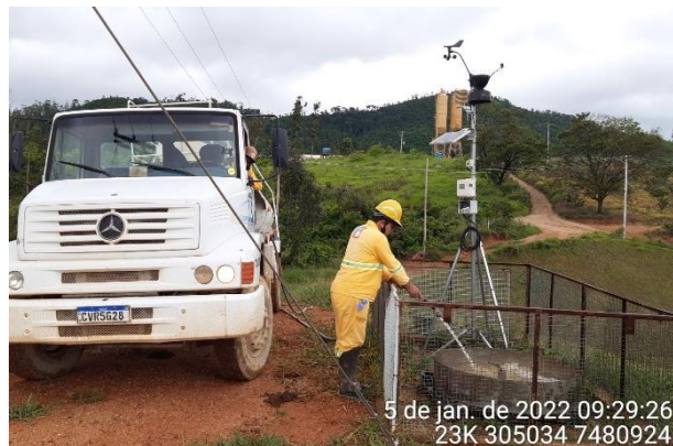
Foto 2 – Tanque do reservatório sendo preenchido com água. (Data: 05/01/2022).
