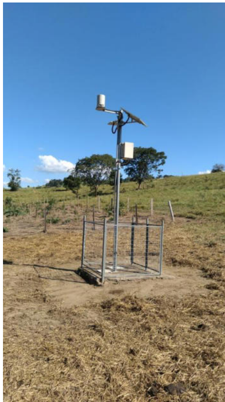
Estação Telemétrica Limpa (longe)
